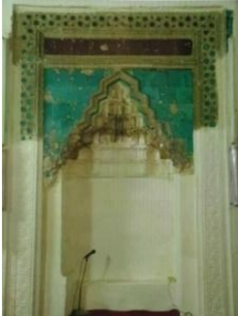
Görsel 20. Konya Tahir ile Zühre Mescidi Cami Mihrabı (Restorasyon yapılmış hali) (Kaynak: Işılak Konak Arşivi)
