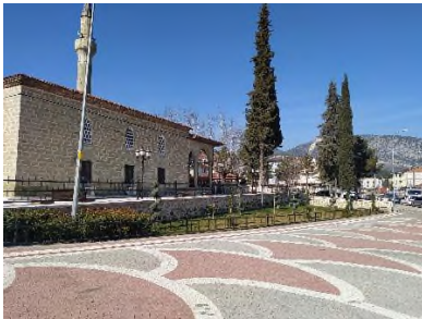
d) Yapının Dış Avlusu ve Doğu Cephesi (Yazar Tarafından Hazırlanmıştır, 2023)
