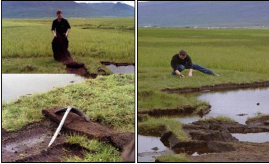
Şekil 13: Çim Kesim Yöntemi ((Sigurðardóttir, n.d.)
