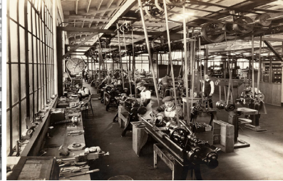
Şekil 3. Elektrikli motorlardan önce takım tezgahı sistemlerindeki güç transmisyonu (Goldsmiths' College, 1894; Pixels, 2016).
