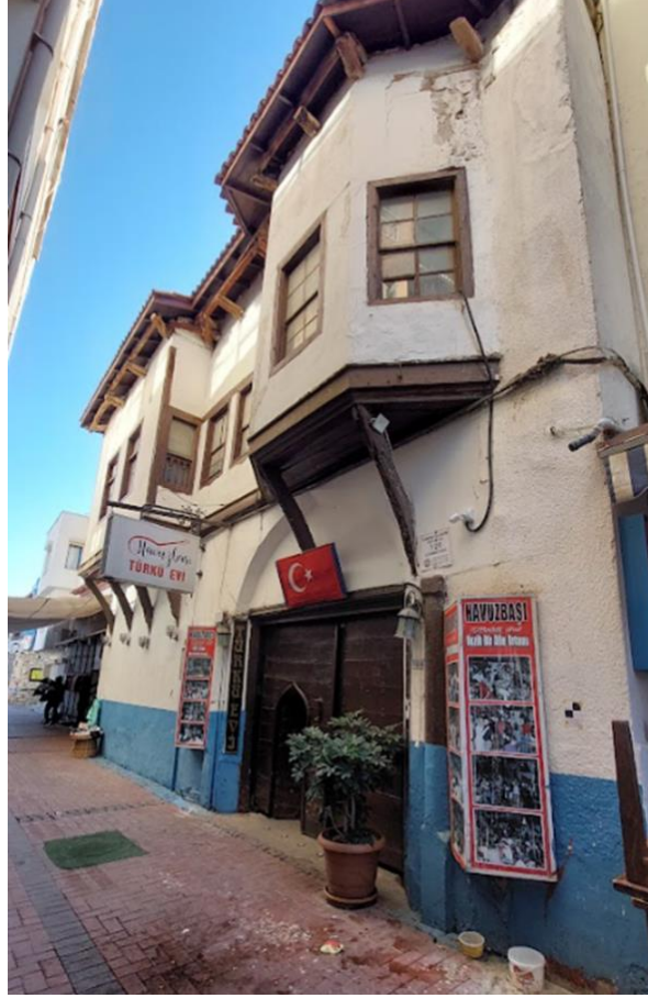
Resim 1. Paşolar Evi Bahar Sokak Cephesi (Selvi, 2023)
