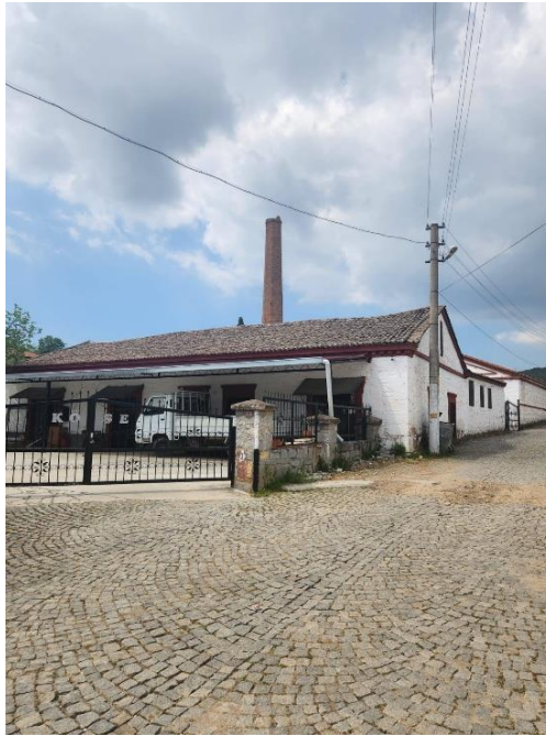
Şekil 6. Köse Zeytinyağı Fabrikası'na meydandan bakış, 2025
