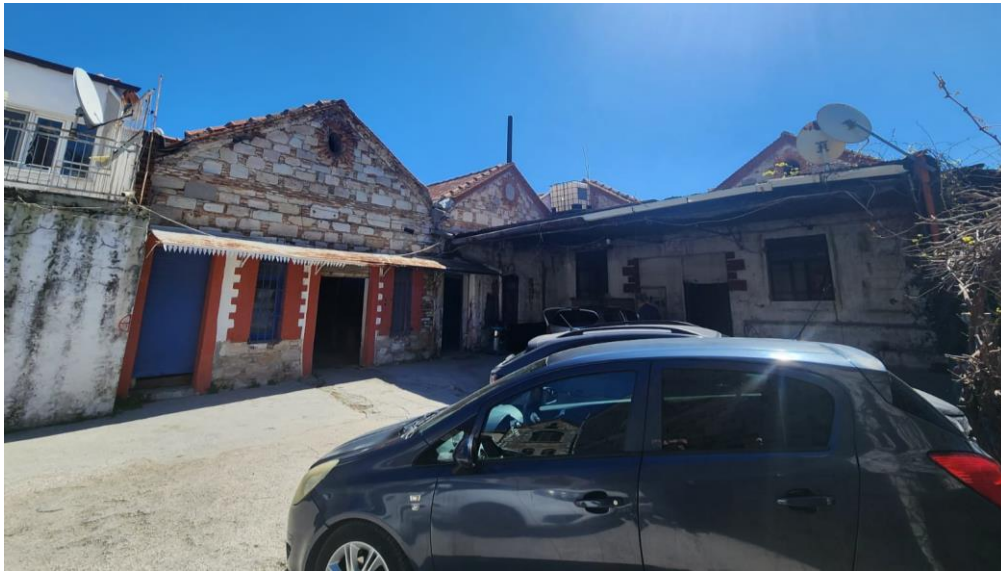
Şekil 3. Urla Hakkı Urad Zeytinyağı ve Un Fabrikası Yerleşkesi, 2025
