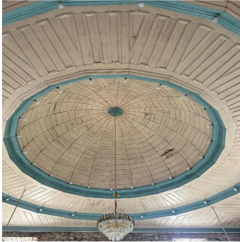
Şekil 1. Demirtaş-Derecik-Karaman Merkez Cami ahşap tavanı
