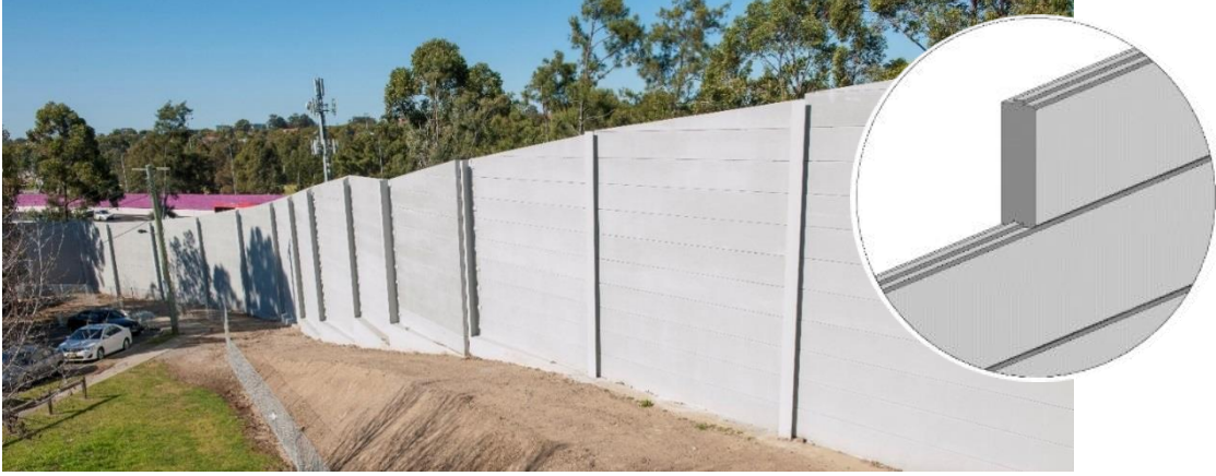
Şekil 5. Donatılı gazbeton gürültü bariyerleri ve panellerin lamba-zıvana profil yapısı
