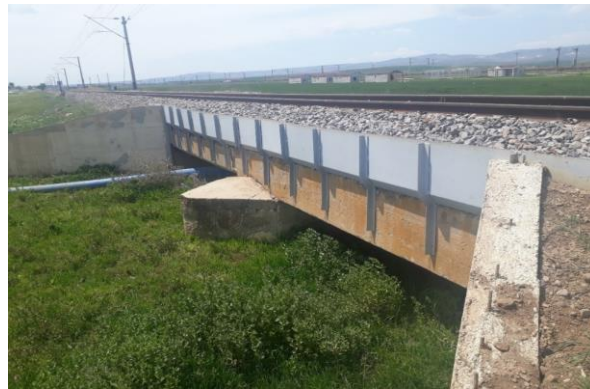
Şekil 3. Temelli istasyonu civarında bulunan geçiş bölgesi
