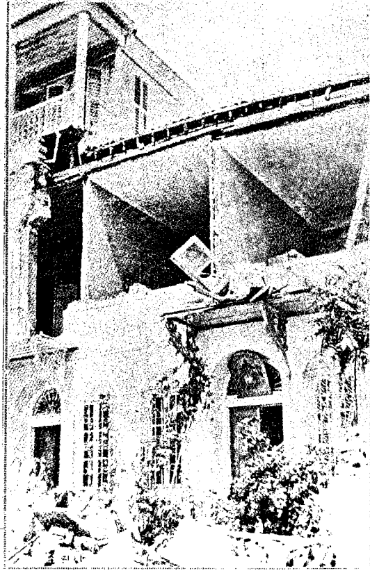
Çanakkale'de en çok hasar gören Yunan Konsolosluğu
