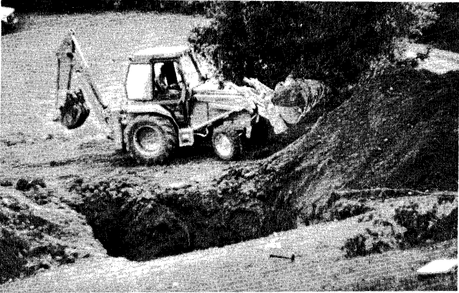
Şekil 7. Trench açılmasının başlangıç aşaması (G'den K'ye doğru bakış)
