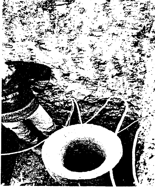
Şekil 3.8 Sismometre yerinde ilk beton büzün yerleştirilmesi
