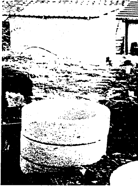
Şekil 3.9 Sismometre yerinde üst beton büzlerin yerleştirilmesi
