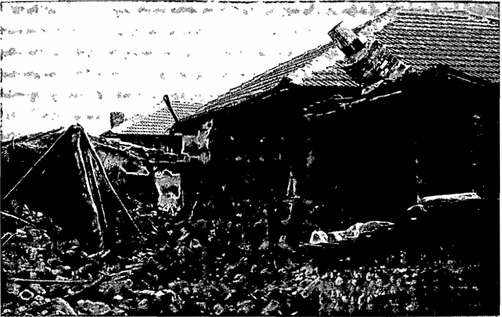
Foto. 21. Kemaliye’de (Alaşehir) batı duvarı batıya doğru yıkılan bir evin güneyden kuzeye görüntüsü.
