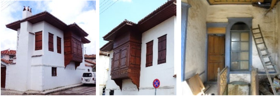
Fot.9-11: Evin sokak cephelerinin görünüşler ile çıkmanın içten görünüşü (Fot.11: E.Soydaş Çakır'dan)
