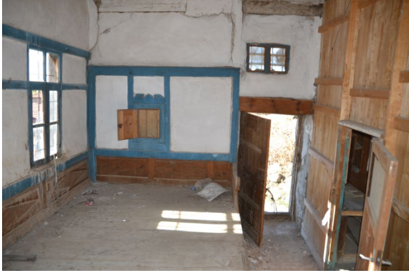
Foto 5: Oda Mekânı Güney Cephe
