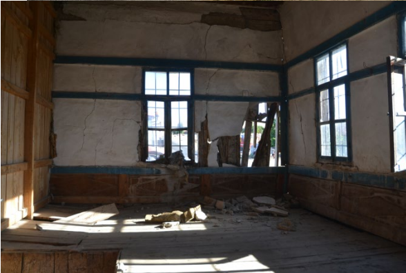
Foto 3: Güney ve Batı Cephe
