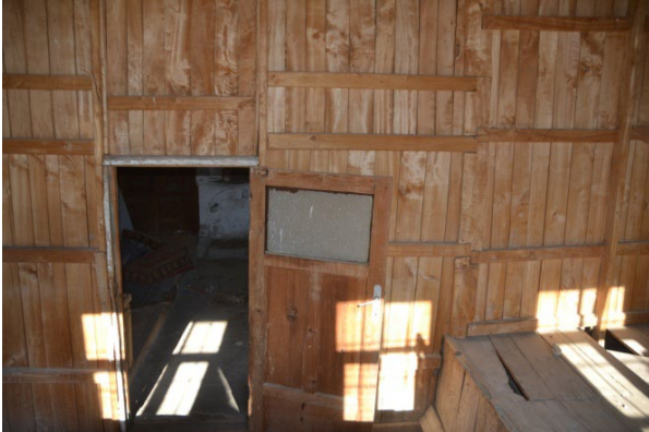
Foto 11-12: Odanın Batı Yönüne Eklenen Ahşap Paravan
