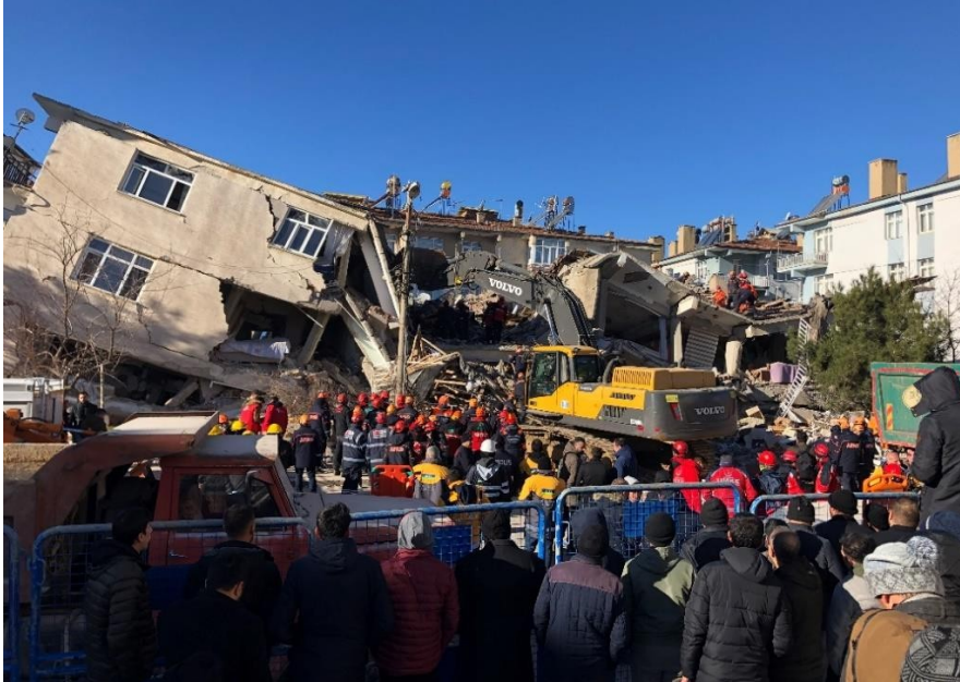
Foto 1. 24 Ocak 2020 Sivrice-Elazığ depreminde yıkılan Dilek Apartmanı.
